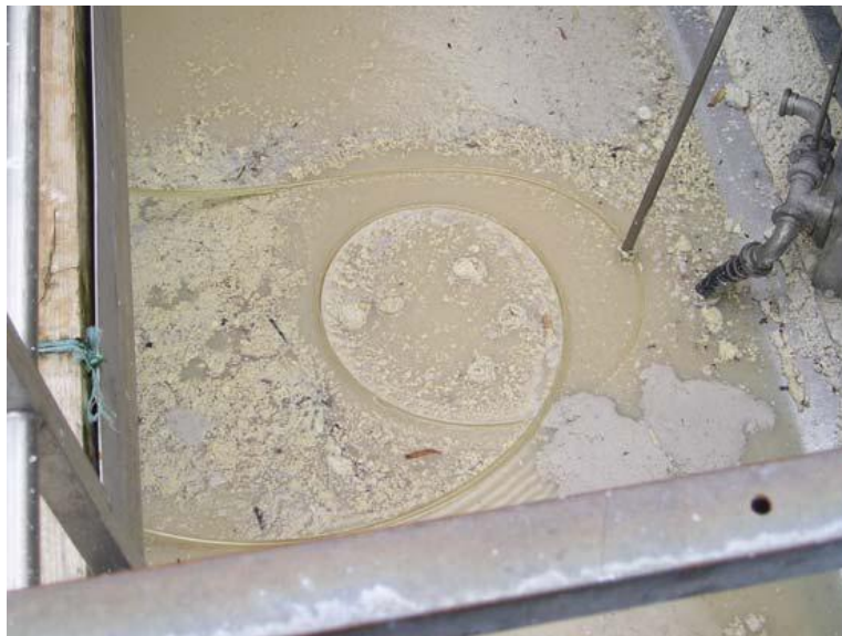
Удаление жировой пены и частиц жира трубой-коллектором.
